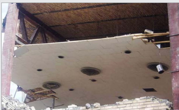
شکل ۱۶: اجرای سقف‌های کاذب با روش سنتی
